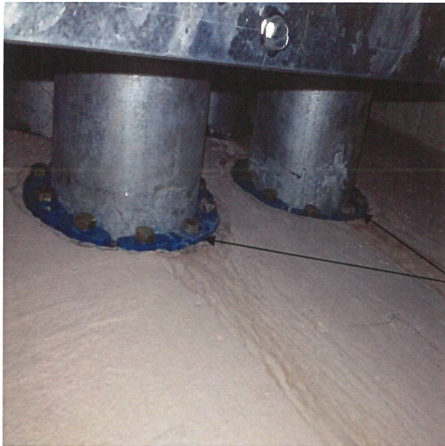
Foundation Conduit Penetrations
